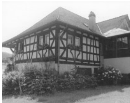
Restaurant Obstgarten Oberlangenhard 8486 Rikon im Tösstal / ZH Tel. 052-383 11 93
